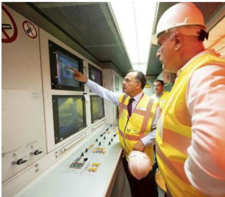
Il sopralluogo del presidente Giani al cantiere Tav di Campo di Marte il 5 agosto
