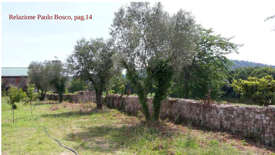
Vista del muro di difesa idraulica presente nella zona orientale dell'area del campeggio
